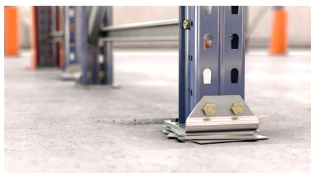
Placas de nivelación correctamente posicionadas
